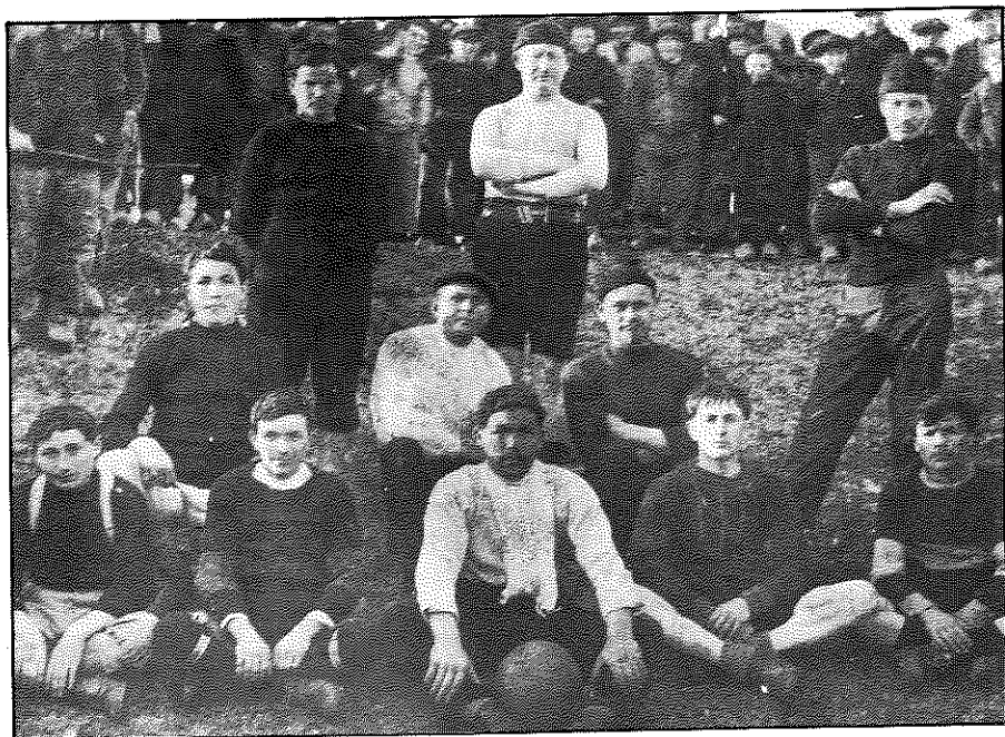
Les premiers footballeurs en 1910-11 au Guilvinec.
